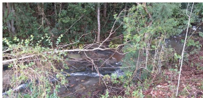
Figura 17 - Barragem 2: leito de rocha do setor jusante.
