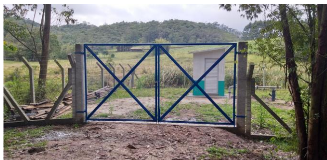
Figura 19 – Portão de entrada.
