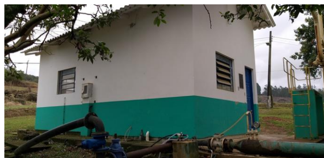
Figura 30 – ETA – Casa de química (vista posterior).
