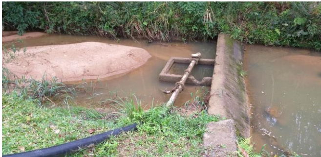
Figura 7 - Barragem 1: estruturas do barramento e poço de sucção
