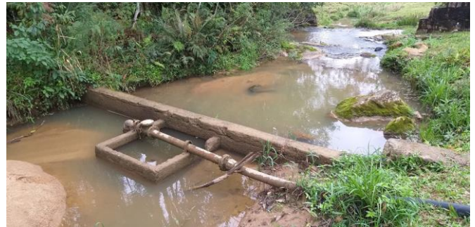
Figura 8 - Barragem 1: estruturas do barramento e poço de sucção
