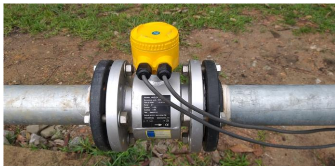
Figura 23 – Macromedidor ultrassônico.
