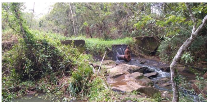
Figura 14 - Barragem 2: barramento e descarregador de fundo.
