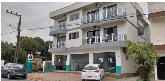
Figura 48 – Fachada do prédio da Agência CASAN.
