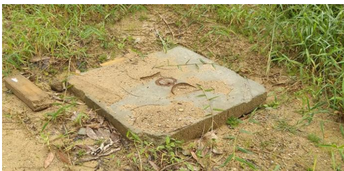
Figura 27 – Registro de descarga da adutora de água bruta do poço.
