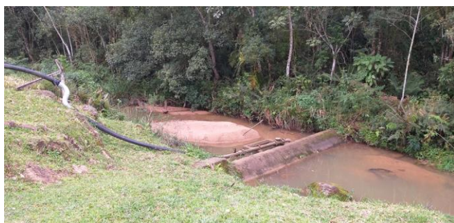
Figura 5 - Barragem 1 (jusante do barramento)
