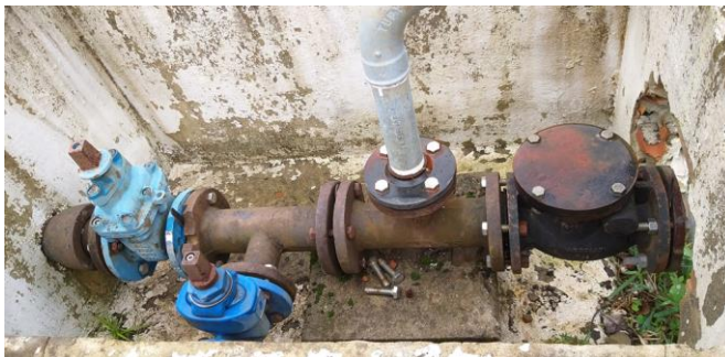
Figura 9 - Barragem 1: Câmara de Manobras
